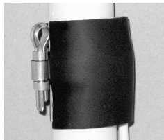
Izolační pásky čidla termoizolační páskou
